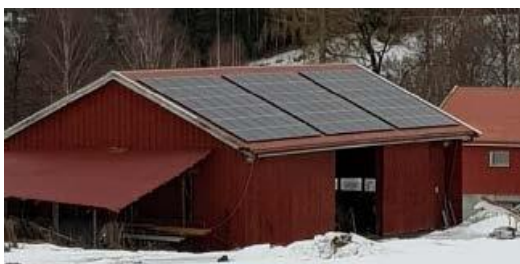
Solceller på tak
