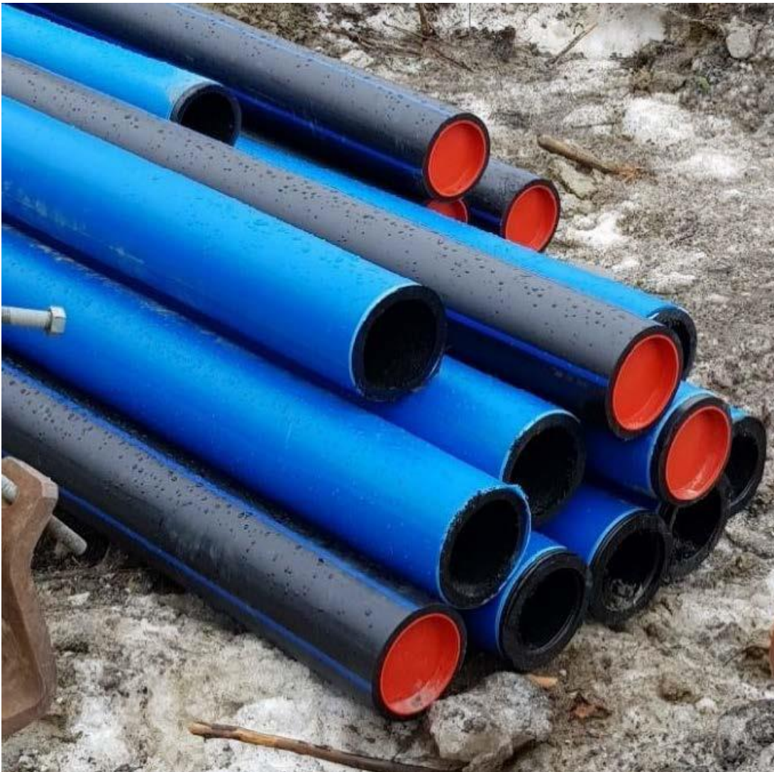
Vann- og avløpsrør
