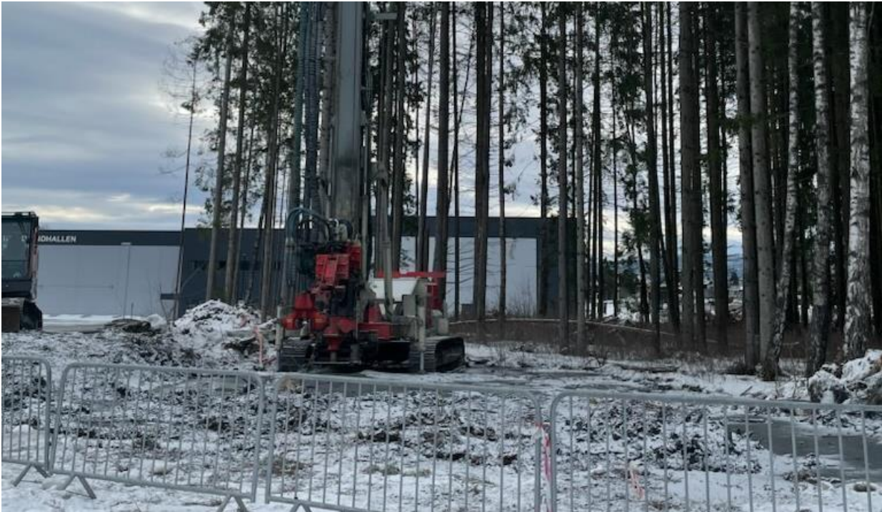
Borerigg til energibrønn, Loesmoen
