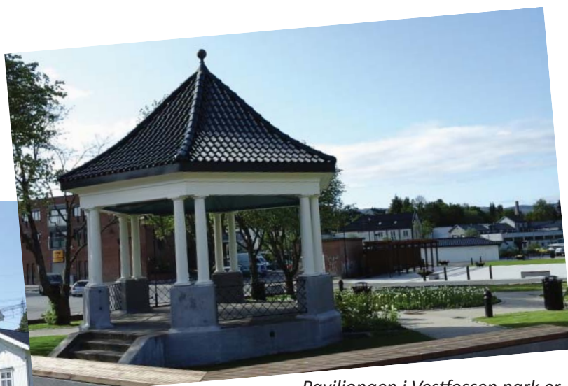
Paviljongen i Vestfossen park er et uvanlig og bevaringsverdig lite byggverk.
