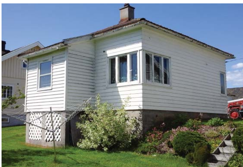
Funkisvilla fra mellomkrigstida på Island ved Vestfossen.
