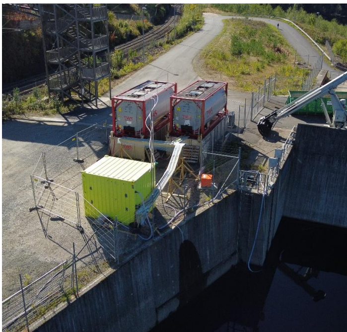
Hoveddoseringsstasjon for kloramin ved Embretsfoss, og rigging av nederste doseringspunkt på Holmenbrua i Drammen, foto: Anders Gjørwad Hagen/Åge Flakk
