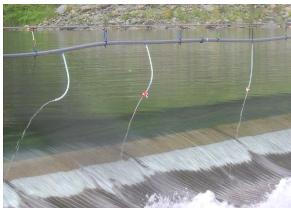
Bilder fra doseringspunktet for klor ved fiskesperra i Driva (foto: Morten Eken)
