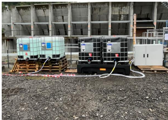
Bilder fra doseringspunktet for klor ved fiskesperra i Driva (foto: Morten Eken)
