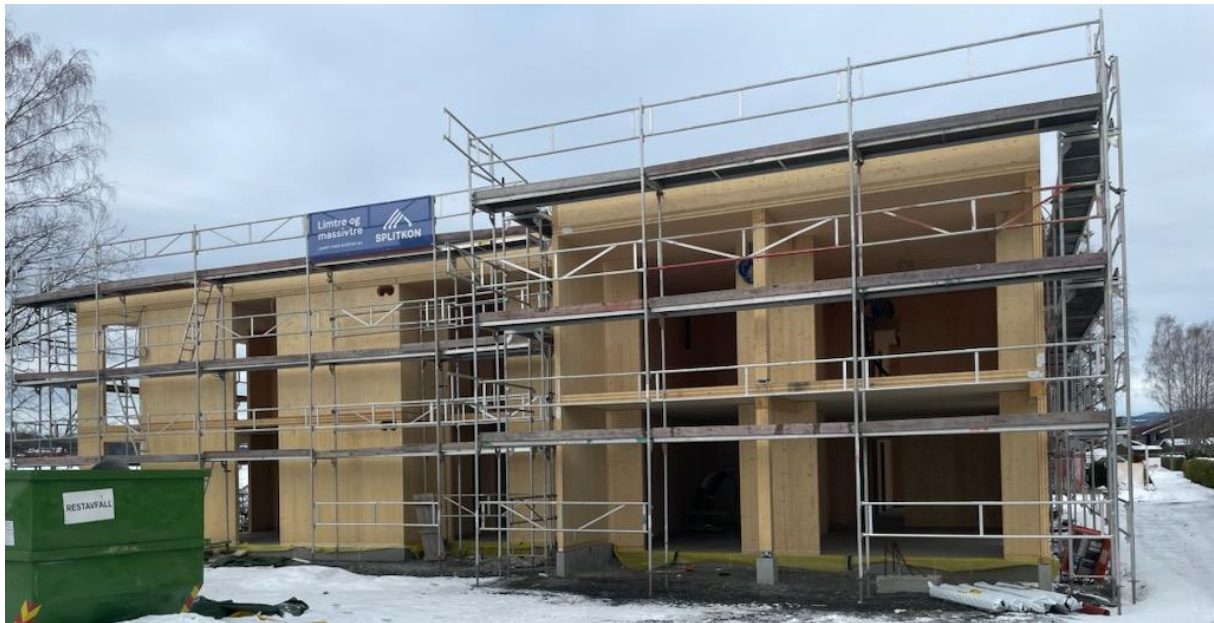
Heltrebygg i Myreveien. Foto: Brynjar Henriksen
