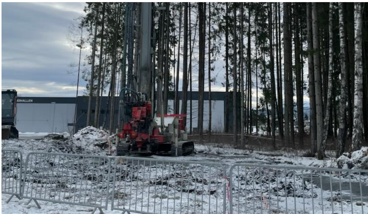
Borerigg til energibrønn, Loesmoen. Foto: Brynjar Henriksen
