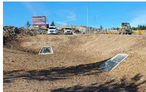
Fodrøyningsbasseng Fiskum. Foto: Øyvind B. Johnsen
