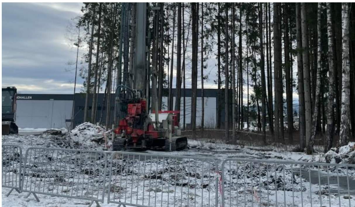
Borerigg til energibrønn, Loesmoen. Foto: Brynjar Henriksen
